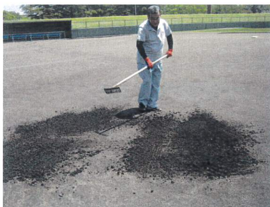
(野球場グラウンド整備作業)
