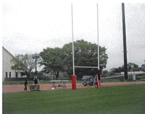
(ラグビーゴール設置作業)
